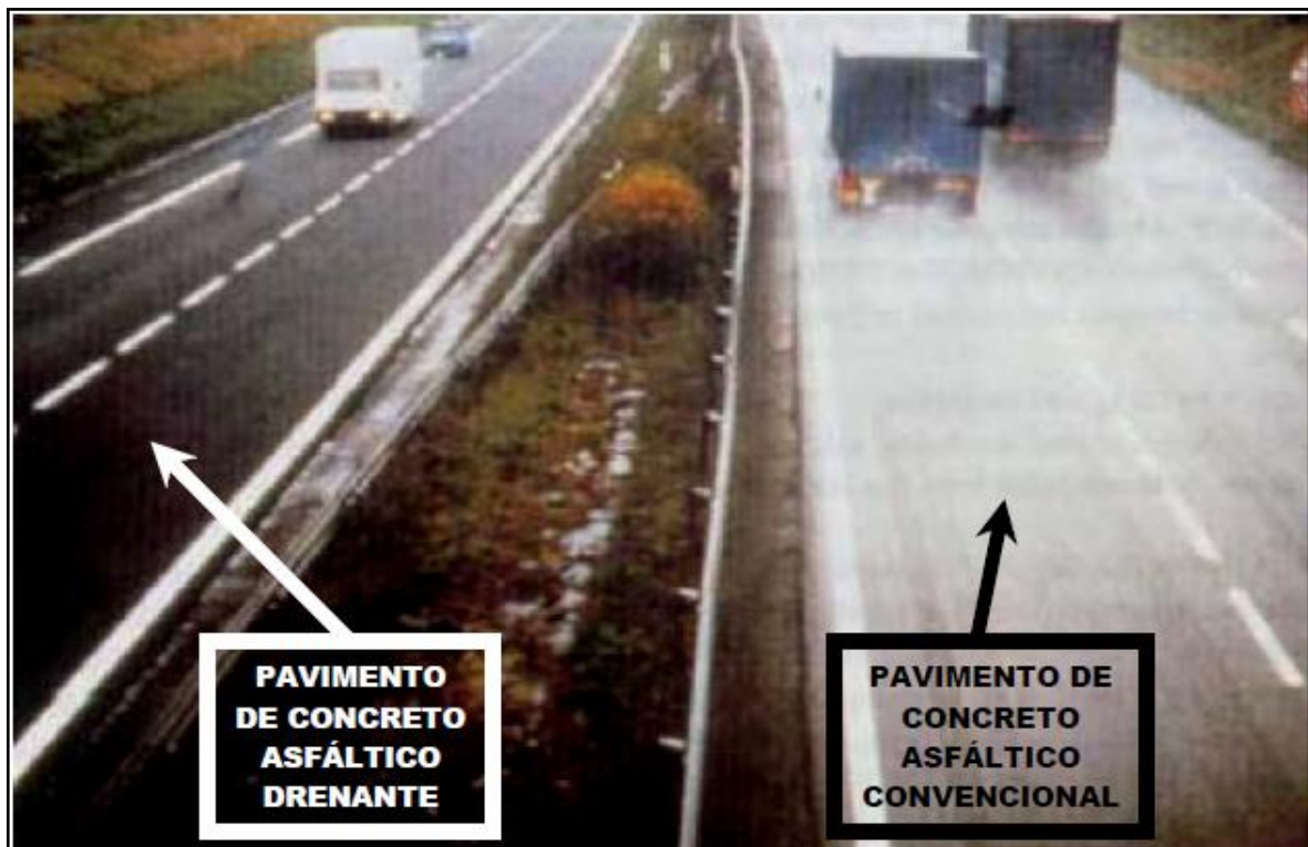
Figura 12 - Formação de Névoa em Pavimento de Concreto Asfáltico Convencional, diferentemente da CPA (DUMKE, 2005)
