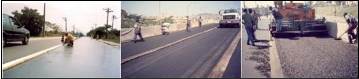
Figura 9 - Etapas de Pintura, Inserção do Gabarito e Espalhamento da CPA (FARAH, 2009)
