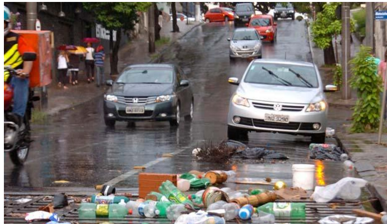
Rua Ituiutaba, também no Prado: a falta de educação da população resulta em bocas de lobo entupidas pelo lixo
